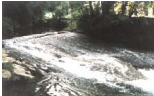
Abb. 8d: Glatte, wenig rauhe Sohlrampe; Betonplatten
