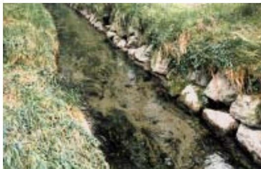
Abb. 4c: Gewässer mit durchlässiger Verbauung des Böschungsfusses: Natursteine locker, vollständig verbaut (100%); Blocksatz unbehauener Steine mit unregelmässigen, relativ grossen
