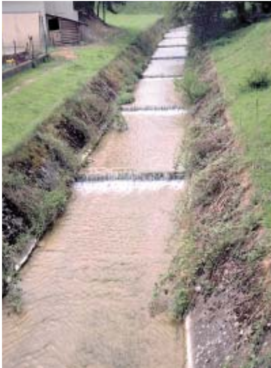
Abb. 6g: Künstlicher Uferbereich: Uferbereich vorhanden, aber vollständig verbaut
