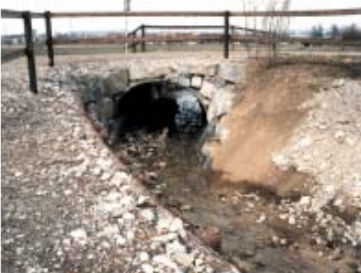
Abb. 10e: Armco - Rohrdurchlass
