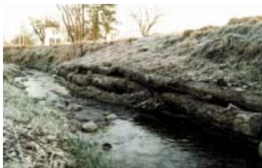
Abb. 4d: Gewässer mit durchlässiger Verbauung des Böschungsfusses: Ufersicherung aus Holz
