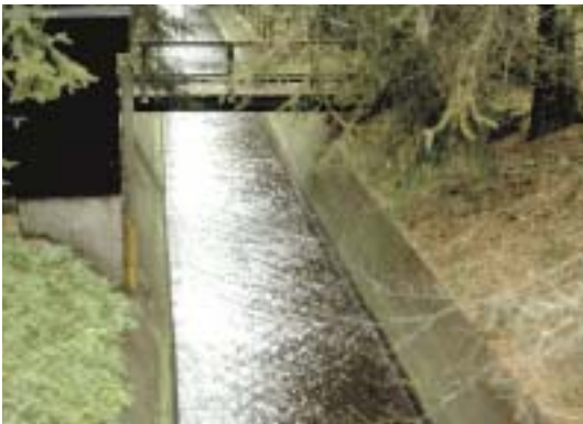
Abb. 4h: Gewässer mit undurchlässiger Verbauung des Böschungsfusses: Betonschale
