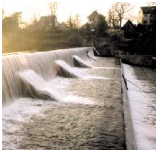
Abb. 7e: Betonierte Abstürze innerhalb eines vierstufigen Wehres
