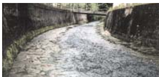
Abb. 3d: Gewässer mit vollständig verbauter, undurchlässiger Sohle (100%); Steinpflasterung
