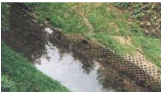
Abb. 4e: Gewässer mit undurchlässiger Verbauung des Böschungsfusses: Betongittersteine
