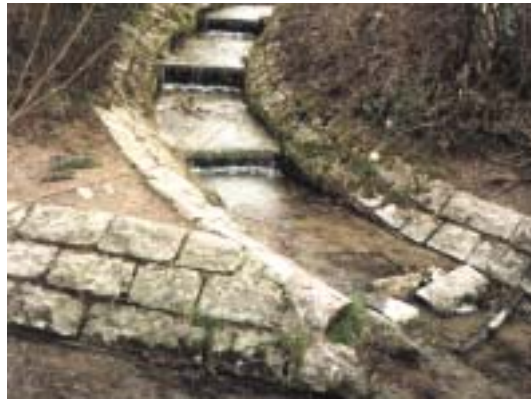
Abb. 3a: Gewässer mit punktueller Sohlenverbauung. Einzelne künstlich angelegte Schwellen oder andere punktuelle Verbauungen machen oft weniger als 10% der Gesamtfläche der Sohle eines Abschnittes aus. Erhöht sich die Anzahl der Querverbauungen pro Abschnittslänge, steigt damit der Verbauungsgrad der Sohlenfläche.
