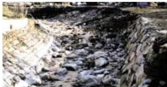
Abb. 3c: Gewässer mit vollständig verbauter Sohle (100%); künstlich angebrachte Rauhsohle
