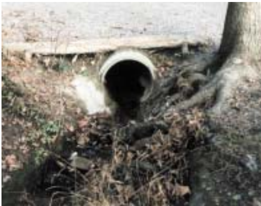
Abb. 10d: Durchlass mittels Betonrohr
