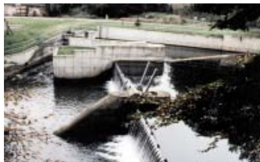
Abb. 9a: Stauwehr zur Wasserentnahme
