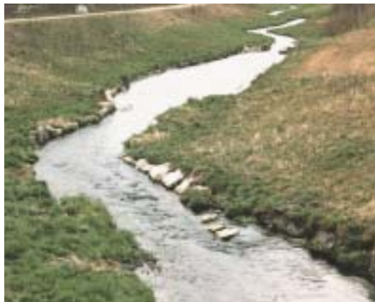
Abb. 4b: Gewässer mit durchlässiger Verbauung des Böschungsfusses: Natursteine locker, mässig verbaut (10-30%); Böschungsfuss nur teilweise mit Natursteinen gesichert
