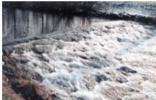
Abb. 8c: Rauhe Sohlrampe aus gesetzten Steinen
