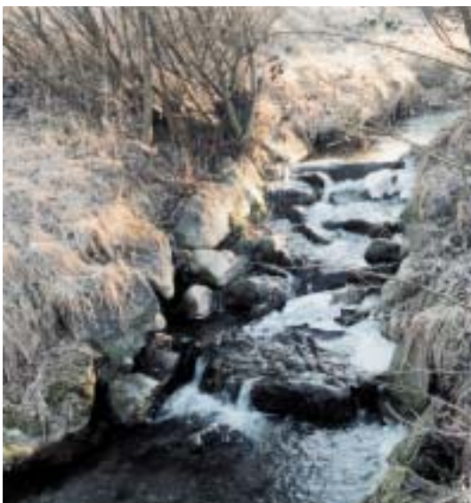
Abb. 8b: Sehr rauhe, aufgegliederte Sohlrampe
