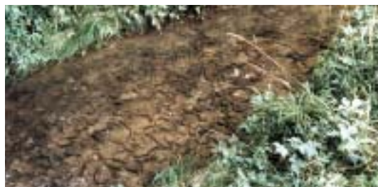
Abb. 3b: Gewässer mit vollständig verbauter Sohle (100%); künstlich angebrachte Steinschüttung
