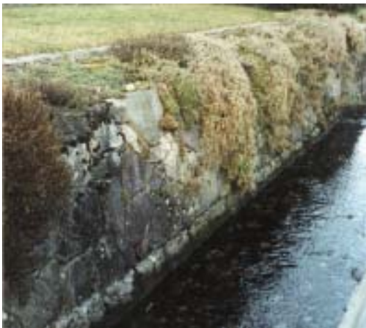
Abb. 4g: Gewässer mit undurchlässiger Verbauung des Böschungsfusses: Mauer, vollständig verbaut (100%)
